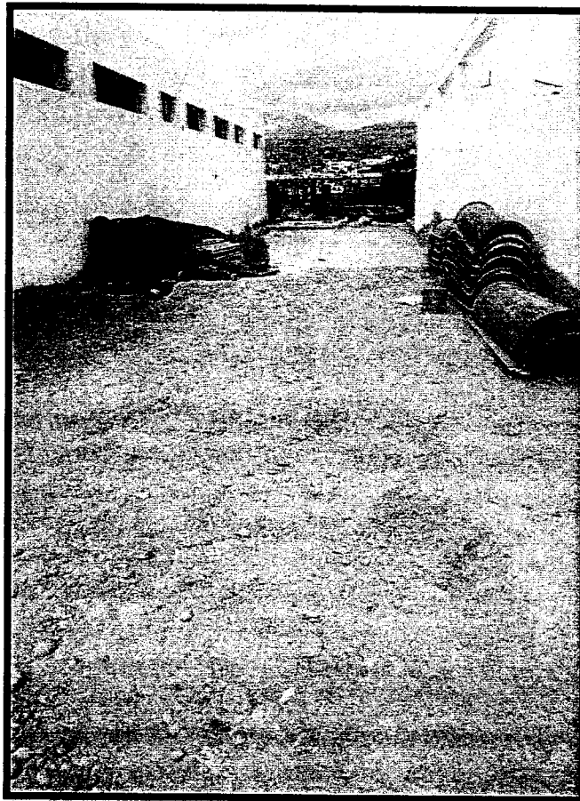
Fotografía 06: Orden y limpieza en obra.
